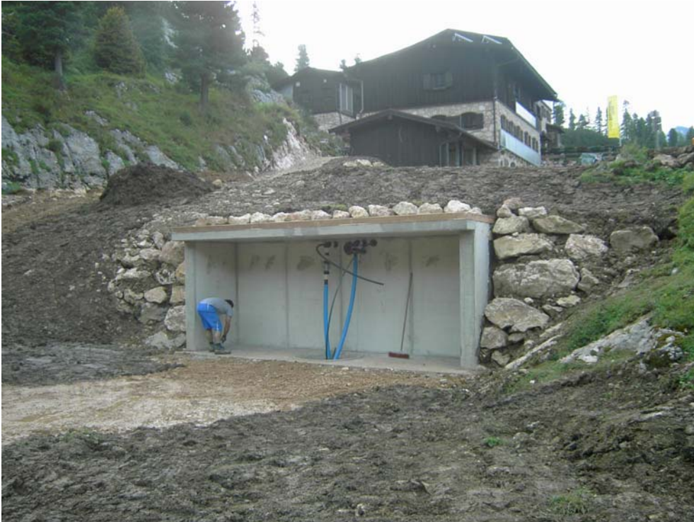
Betriebsgebäude der Filtersackanlage
