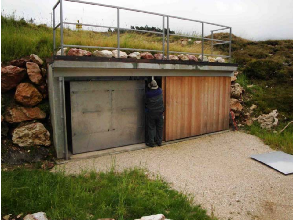
Einbau Aufhängung Filtersäcke
