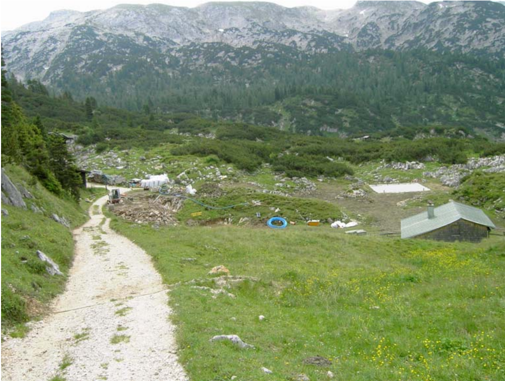
Baustellenumfeld der Abwasserreinigungsanlage
