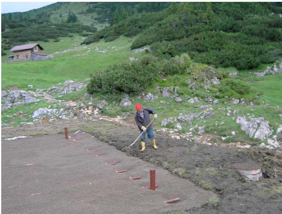
Errichtung bepflanzter Bodenfilter
