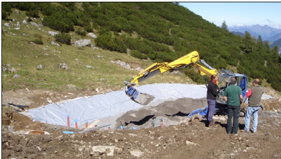
Bild 6: Errichtung der biologischen Stufe der Kläranlage
