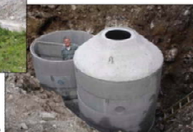
Setzen der Mehrkammergrube
