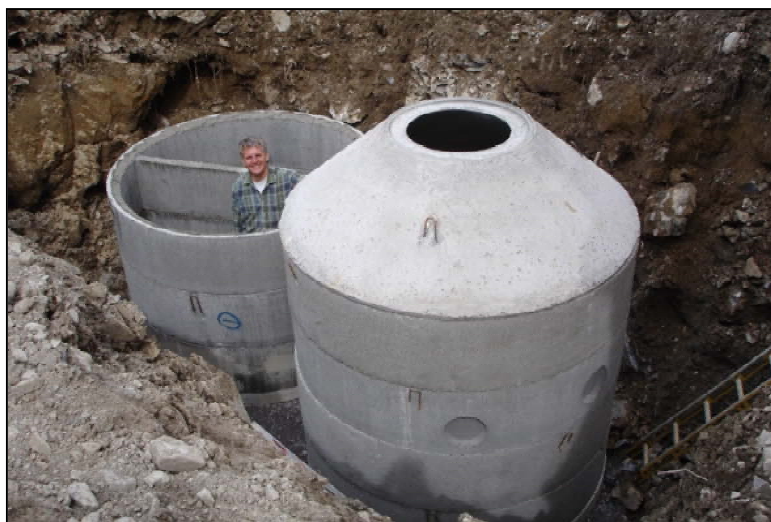
Bild 5: Errichtung der Mehrkammergrube
