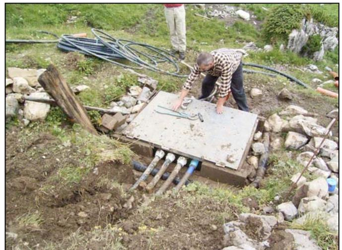
**Bild 12: Montage der neuen Behälterabdeckung**
