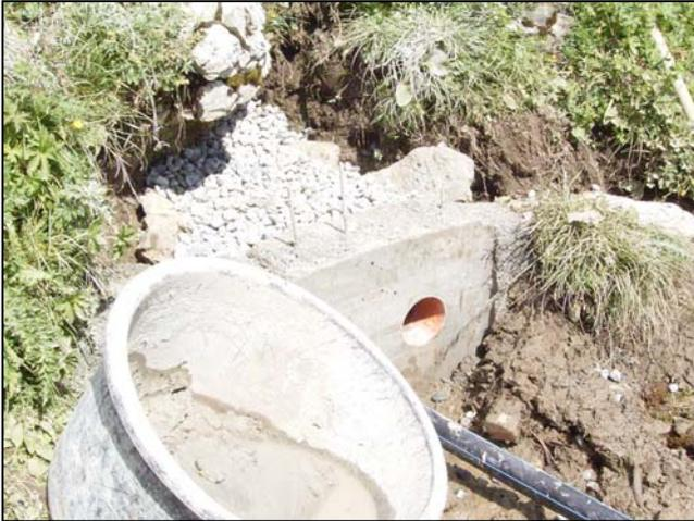
**Bild 9: Kiesschüttung um die Fassung**
