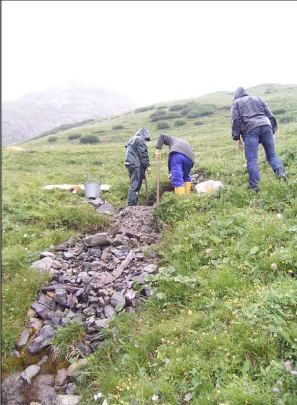
Die bestehenden wasserführenden Stellen im Hang wurden freigelegt, mit Ton abgedichtet und mit einer Kiesschüttung umgeben. Gegen das Eindringen von Tieren in die Entnahmestellen wurden Froschklaappen angebracht. Die Rohrleitungen wurden an einzelnen Entnahmestellen angepasst und mit dem Zwischenbehälter verbunden.
