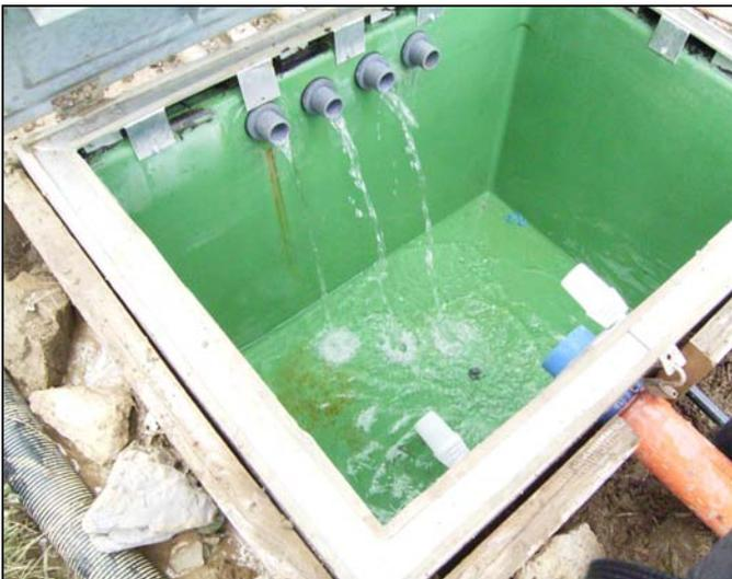
**Bild 11: 1. Zwischenbehälter mit neuen Anschlüssen**
