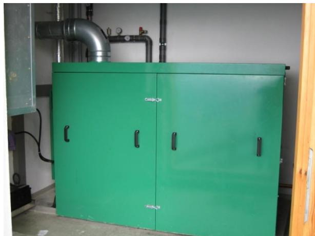
5.2.6. Fertiges BHKW mit Schalldämmung
