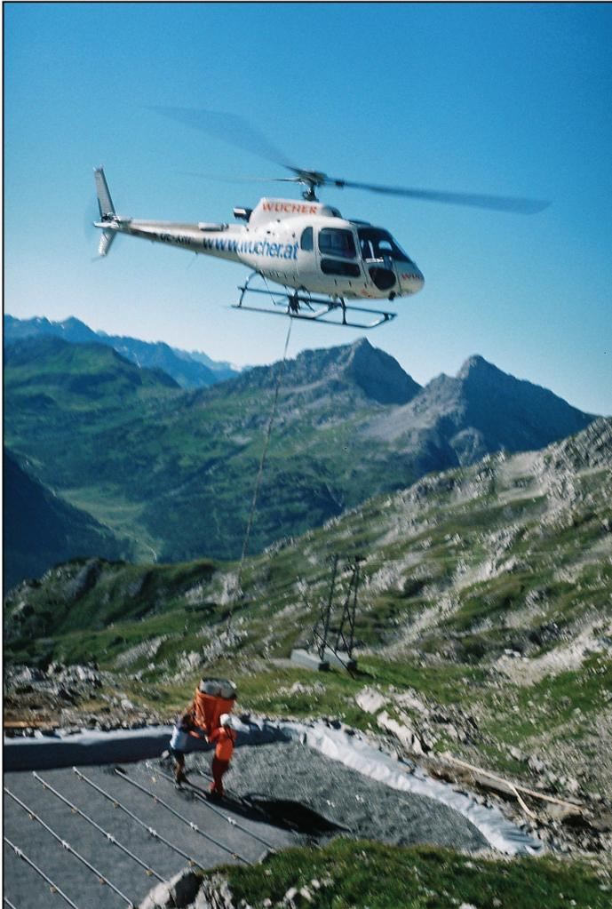
Alles Material für den Bau der Abwasseranlage wurde an mehreren Tagen mit dem Hubschrauber angeliefert.
