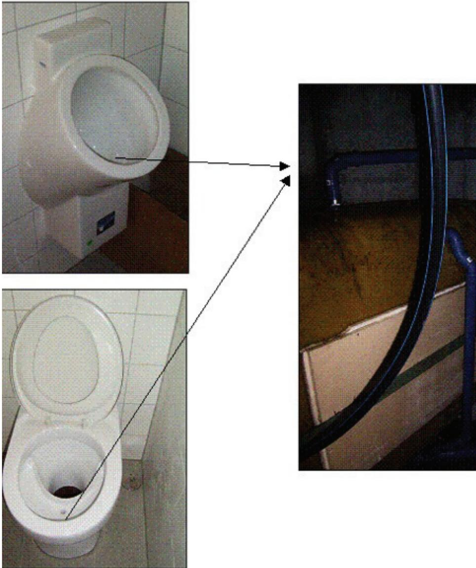
Die Flüssigkeit aus der Separationstoilette sowie den wasserlosen Urinalen fließt in den Speichertank. Die gespeicherte Flüssigkeit wird in kleine Gebinde gepumpt und abtransportiert und kann auf der nahe gelegenen Alpe entsorgt werden.
