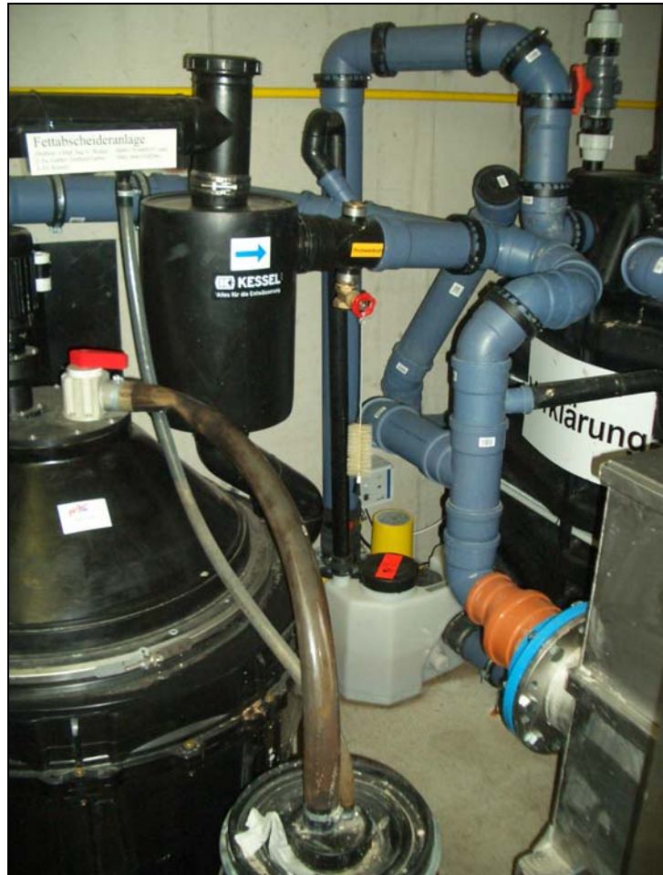
Bild 9: Nachrüstung Hebeanlage [2009]
