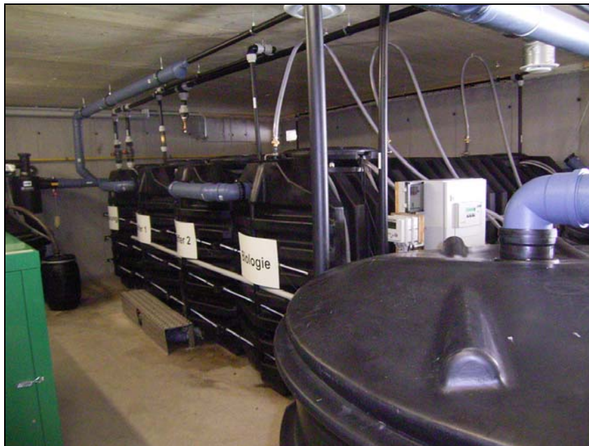
Bild 6: Membrankläranlage Oppererhütte (2008)
