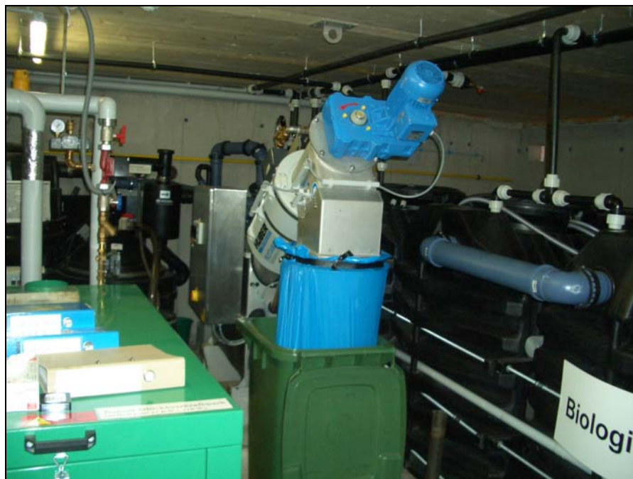
Bild 8: Nachrüstung Siebanlage [2009]
