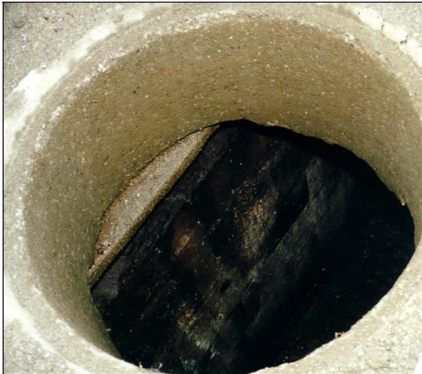
**Bild 5: Mannloch der bestehenden 2 Kammergrube**
