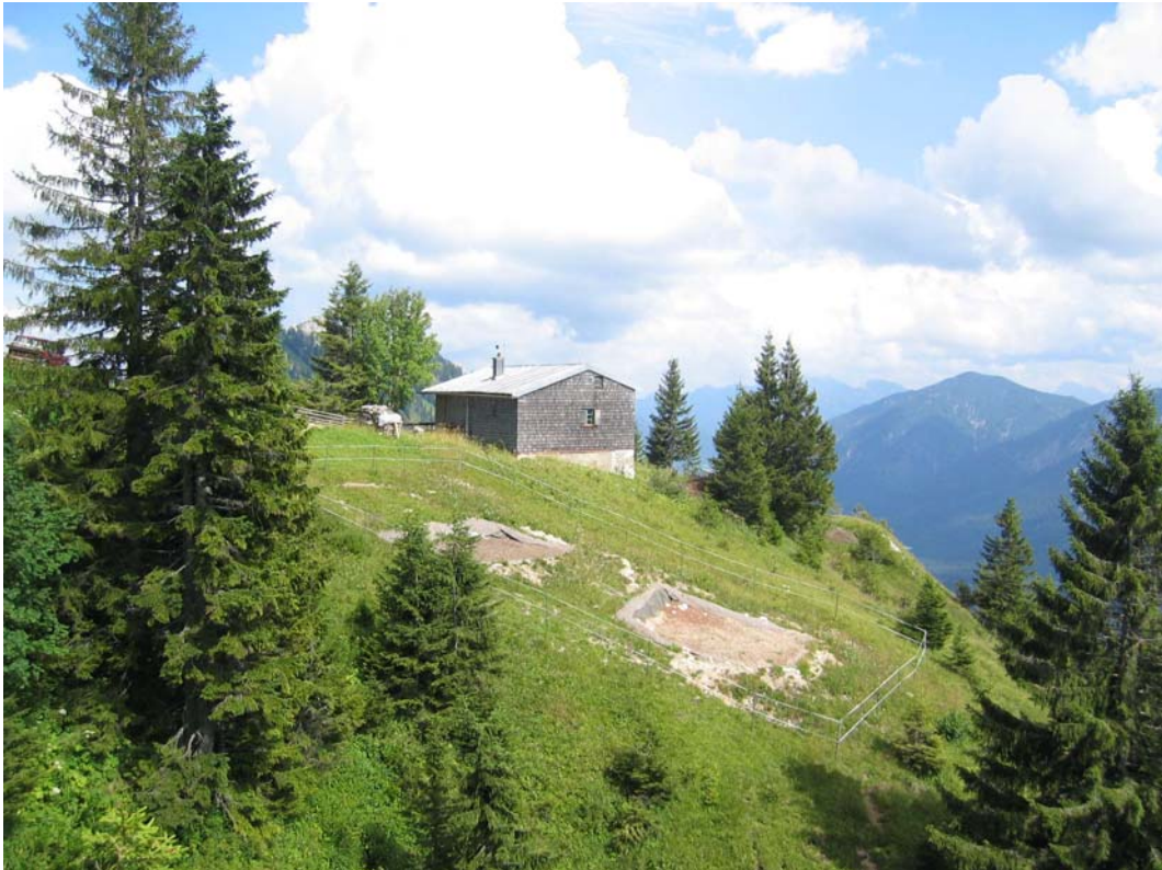
Abb. 6: Filterbeete der Abwasserreinigungsanlage (ein Jahr nach Errichtung)
