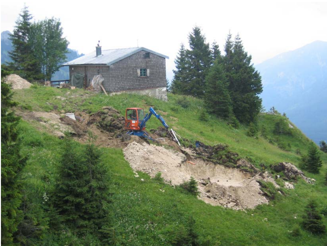
Abb. 4: Aushub der Becken für die Filterbeete
