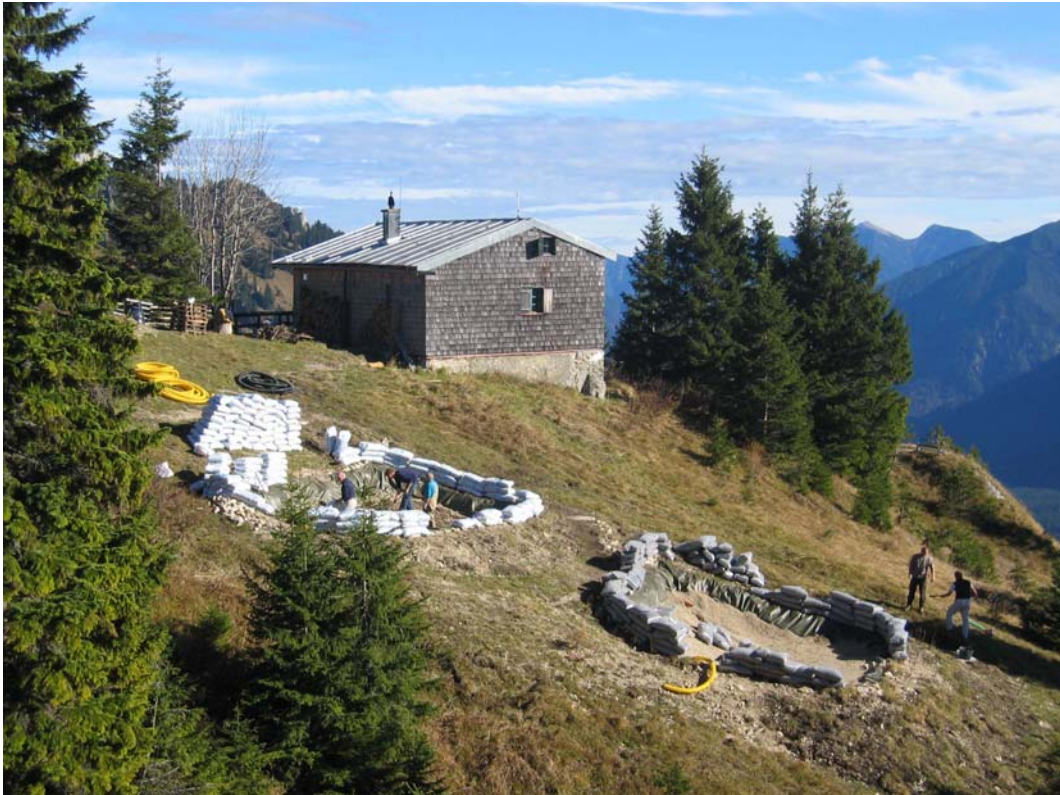
Abb. 5: Einbau des Filtermaterials
