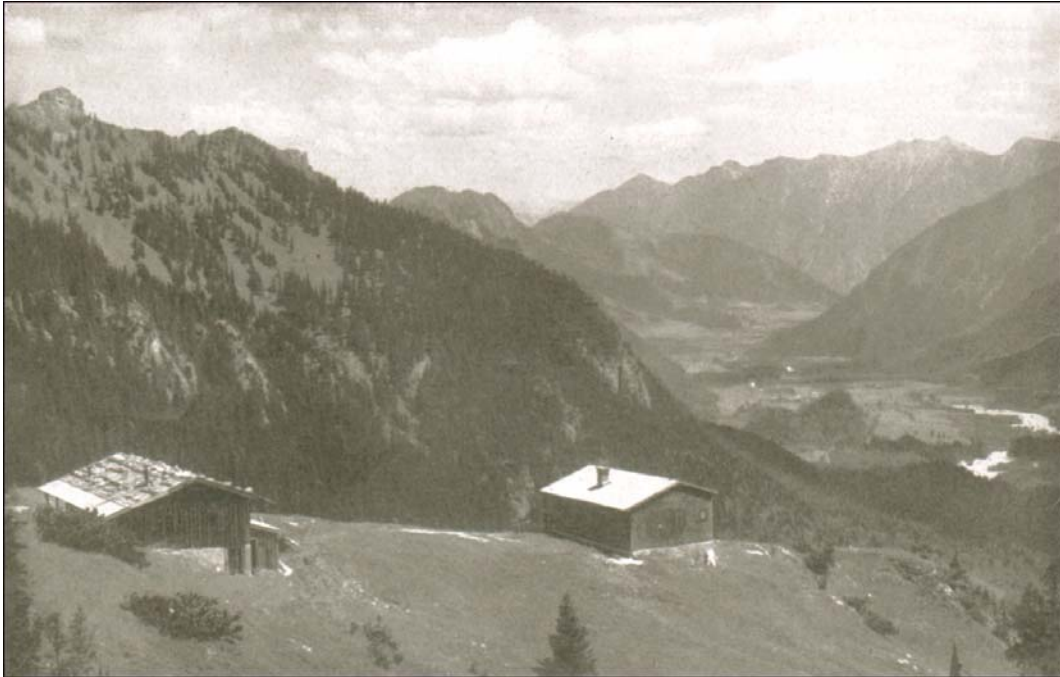
Abb. 1: Die Brunnenkopfhäuser (Aufnahme ca. 1930)
