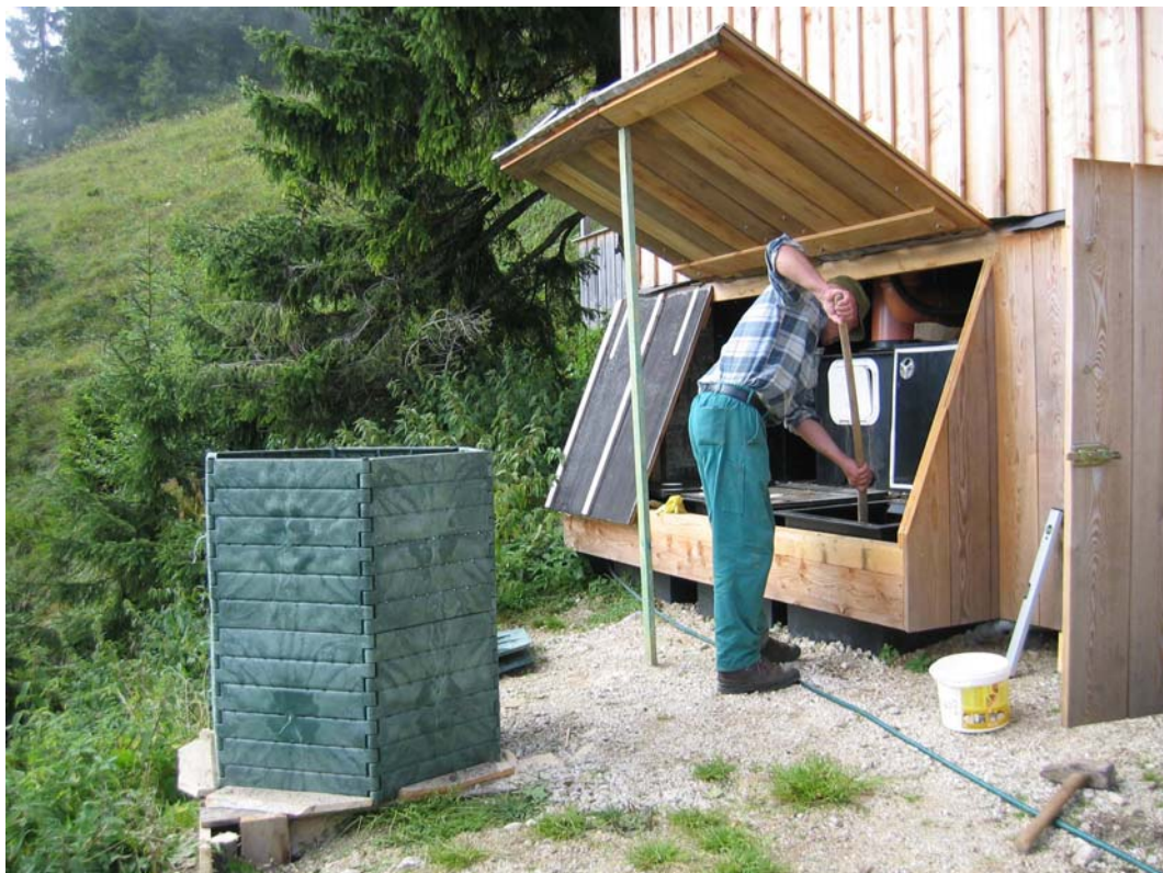
Abb. 2: Kompostentnahme aus den Trockentoiletten
