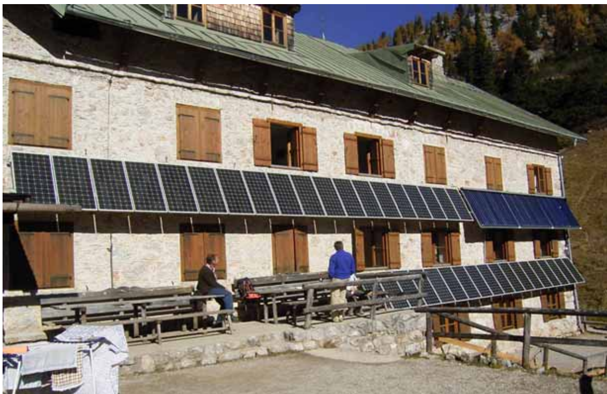
Abbildung 6: PV-Module und Vakuum-Röhrenkollektoren (rechts obere Reihe) an der Südfassade der Hütte
