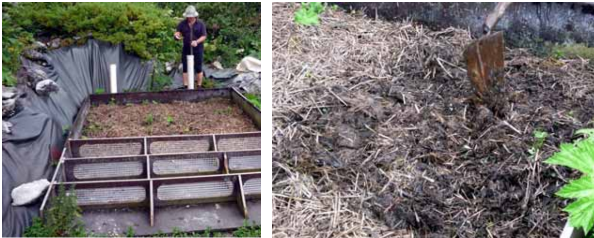
Abbildung 15: Optimiertes Vererdungsbeet mit guter Kompostierungsrate durch Zusatz von Stroh und Umschichtung
