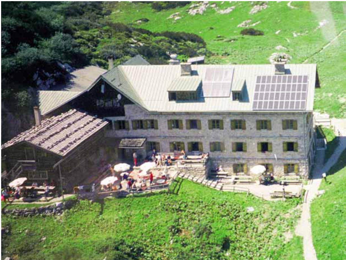
Abbildung 1: Solarthermische Anlage (zwischen den Dachgauben) und Photovoltaikanlage rechts auf dem Dach
