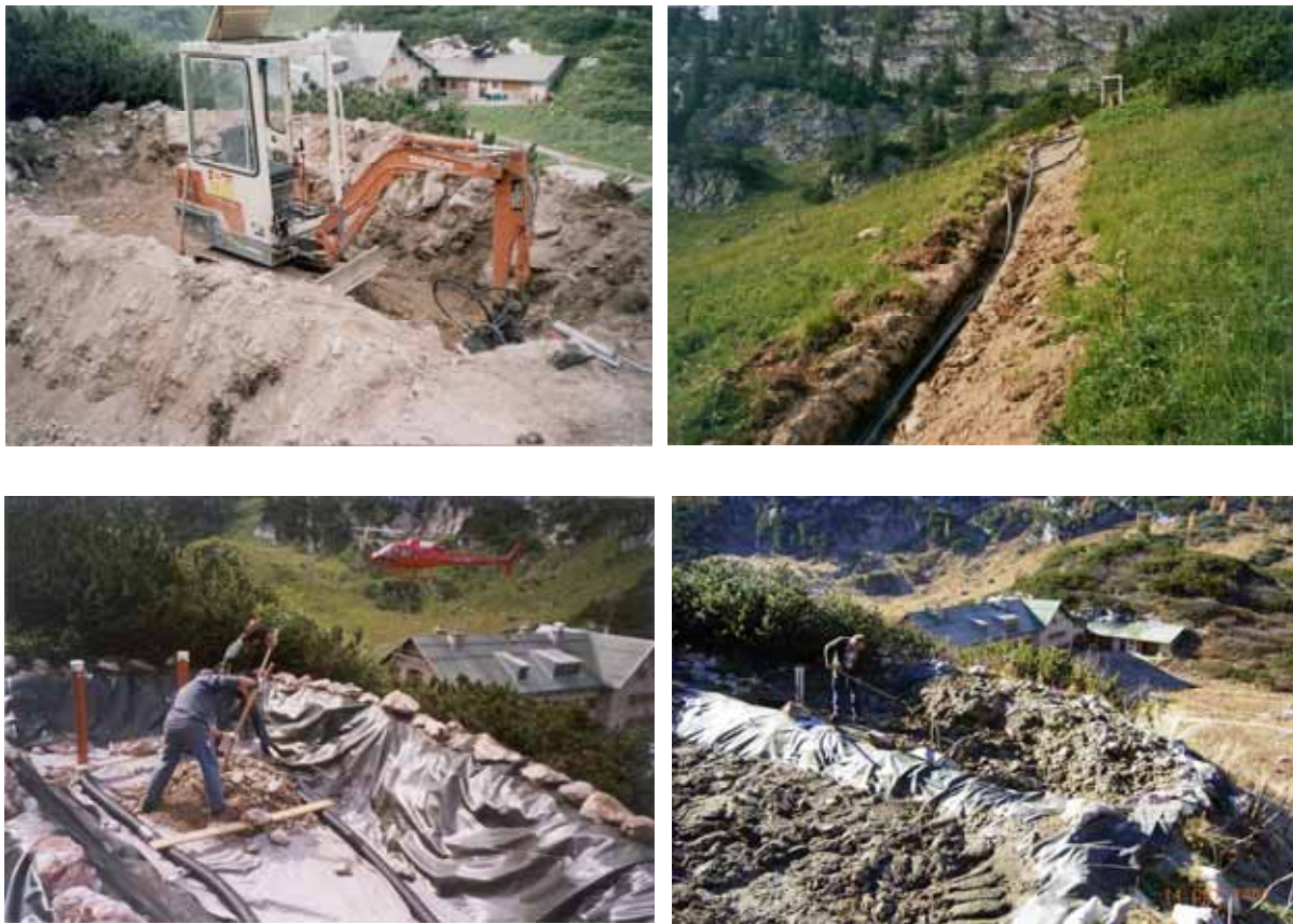
Abbildung 14: Bau des Vererdungsbeets (oben links) mit Zuleitung (oben rechts) und Kieseinfüllung (unten links), Schlamm mit Oberflächenverkrustung (unten rechts)
