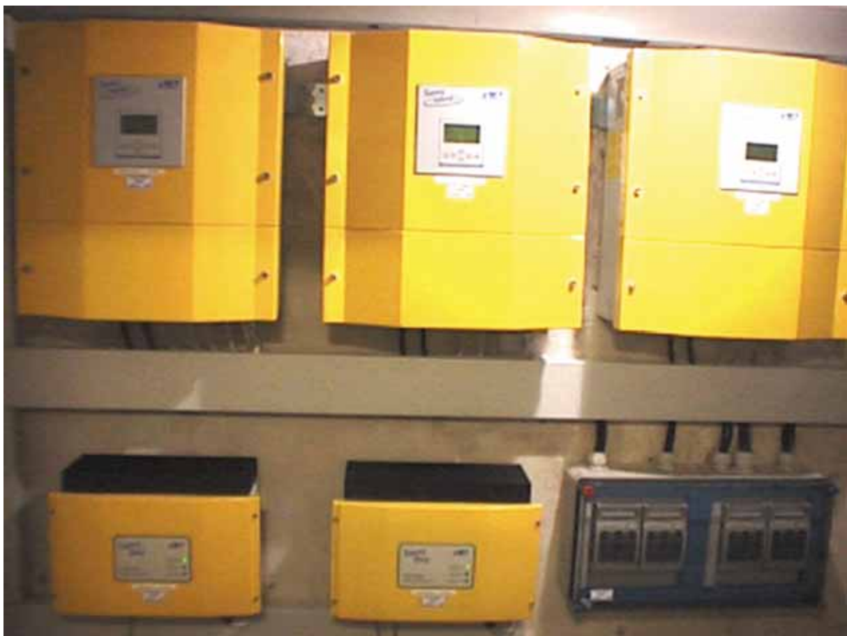
Abbildung 2: drei Bidirektionale Sunny-Island Wechselrichter 4500 (oben), zwei Sunny Boy 2500 PV-Wechsrlrichter (unten links); Batfuse DC-Batterietrenner (unten rechts)
