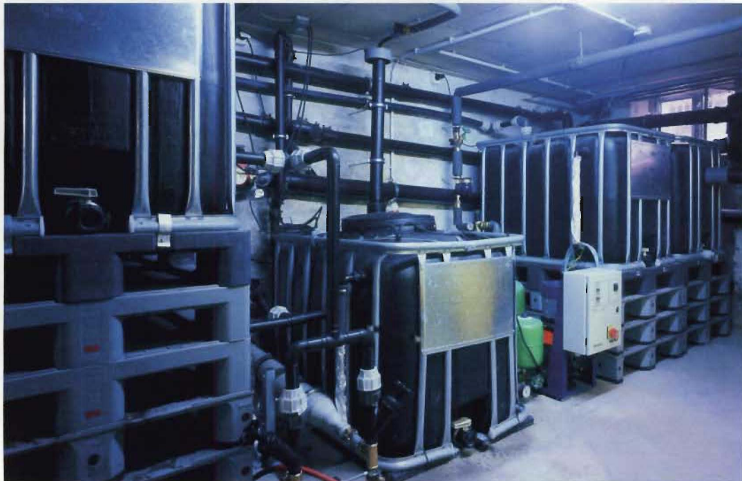
Grauwasseraufbereitung, Rechts: 2-stufige Vorklärung
