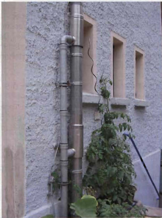
Zweifacher Rohrfilter für Dachablauf
