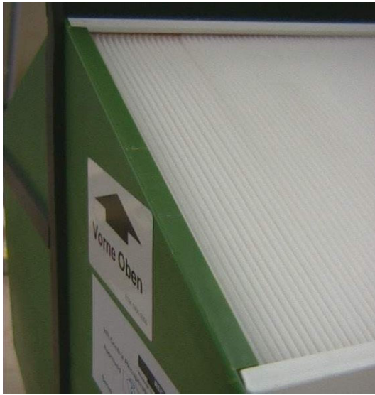
Bild 37 Detailansicht des Rekuperativ-Wärmeübertragers
