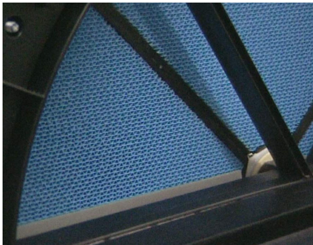
Bild 30 Detailansicht des Rotationswärmeübertrager-Bauteils
