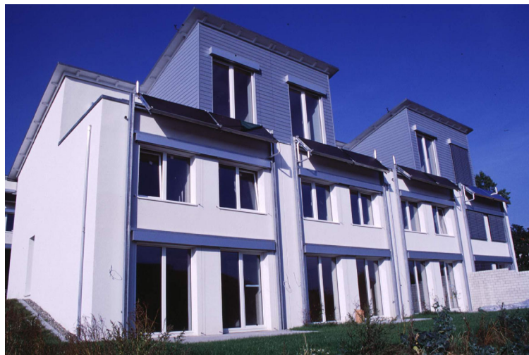
Bild 46 Südwest-Ansicht einer Reihenhauszeile (PH-Standard) in der Siedlung „Am Eselsberg“, Ulm
