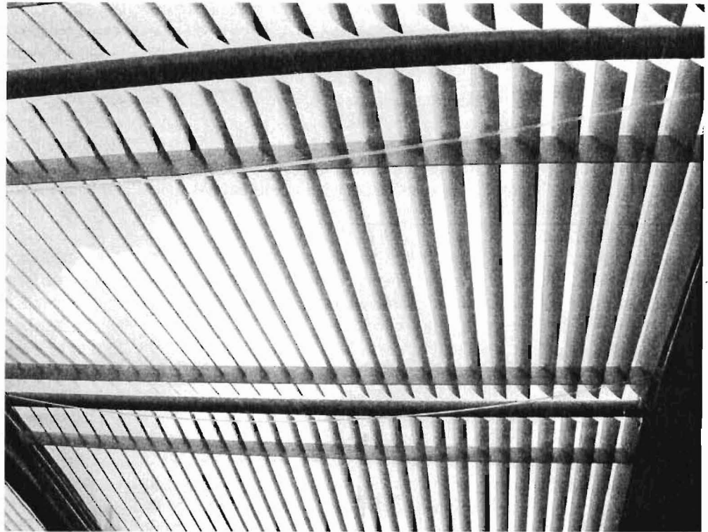
Transparenter Sonnenschutz im Glasdachbereich: RETROFlex-Lamellen
