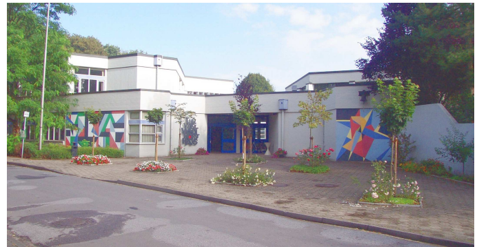
Abbildung 9.1.1.4 Vorderansicht des Hauptgebäudes.
