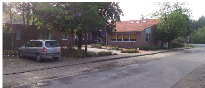
Abbildung 9.1.1 –6 Der neue Kindergarten
