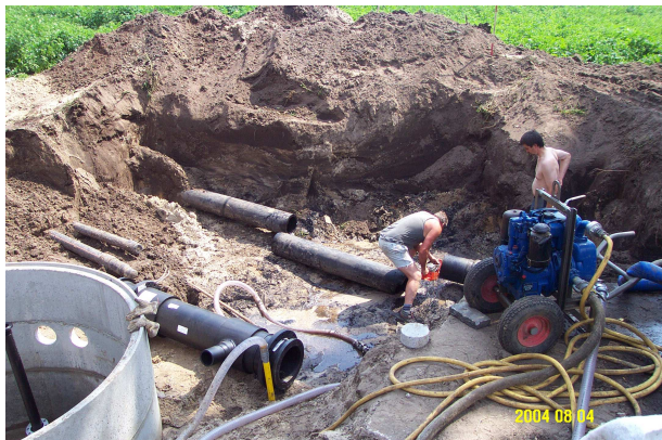
Abb. 9.2.3.4-1 Trennen der Abwasserleitung
