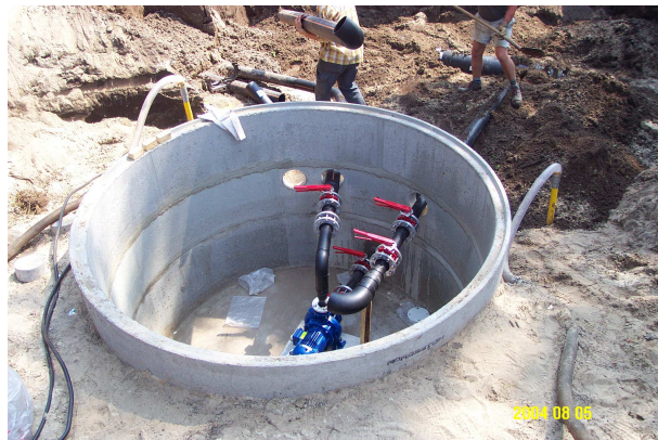
Abb. 9.2.3.4-2 Abwasserschacht
