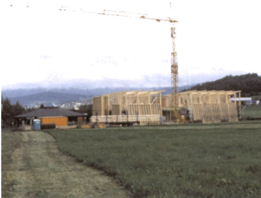
Abb. 24: Das Naturpark-Informationshaus nach Erstellung der Rohkonstruktion
