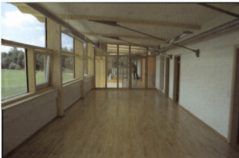
Abb. 49: Büro mit Leuchten
