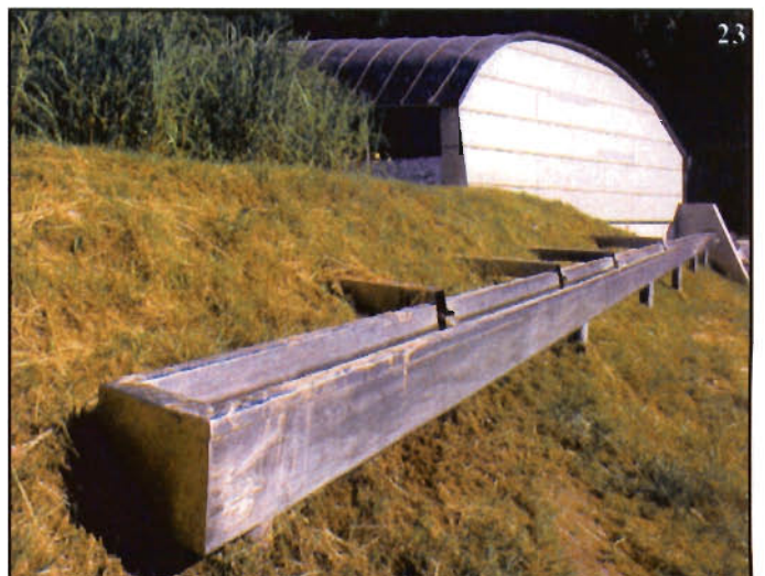
23: Die Wasserrinne an der Ostseite
