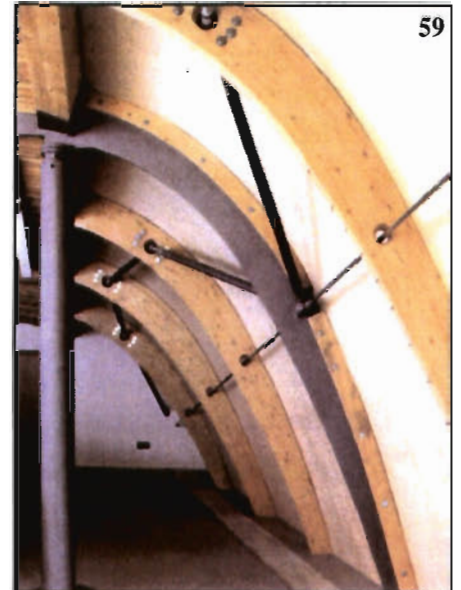
58: Konstruktionsskizze des Druckstrebensystems 59: Die frei gebogenen Sparren mit den Druckstrebenunter dem südlichen Dach
