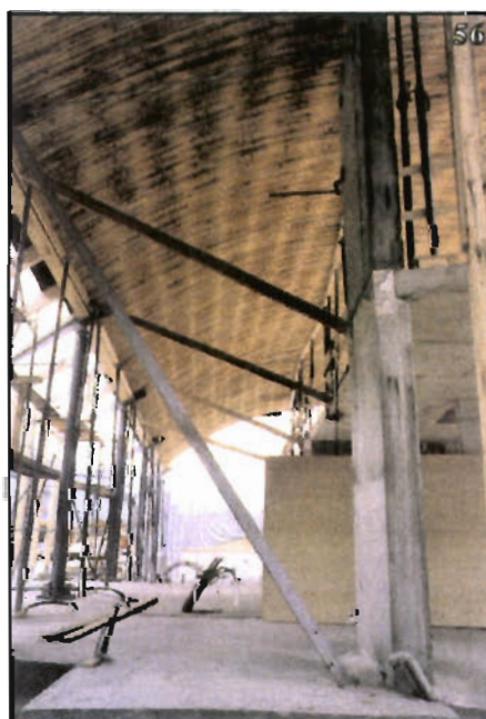
56: Die Brettwerkschale im Rohbaustadium
