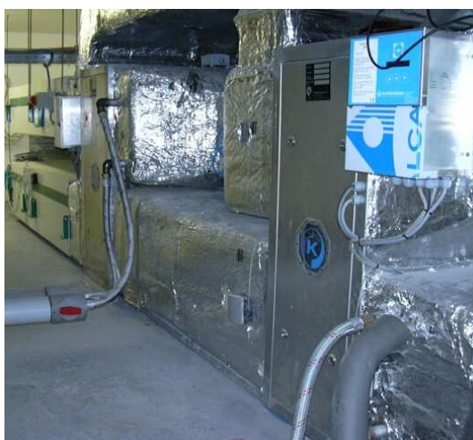
Bild 3.6: Seitenansicht der ausgeführten sorptiven Lüftungsanlage (oben Konstruktionszeichnung, unten Fotos)
