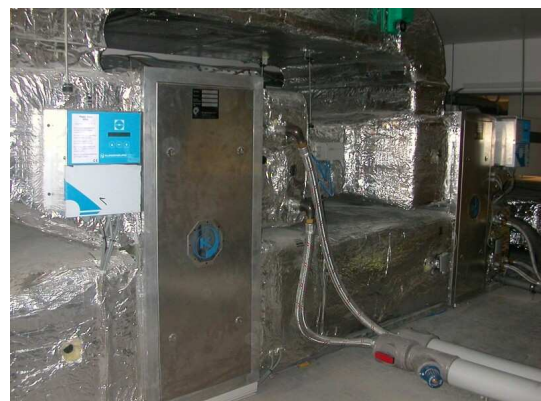
Bild 3.6: Seitenansicht der ausgeführten sorptiven Lüftungsanlage (oben Konstruktionszeichnung, unten Fotos)
