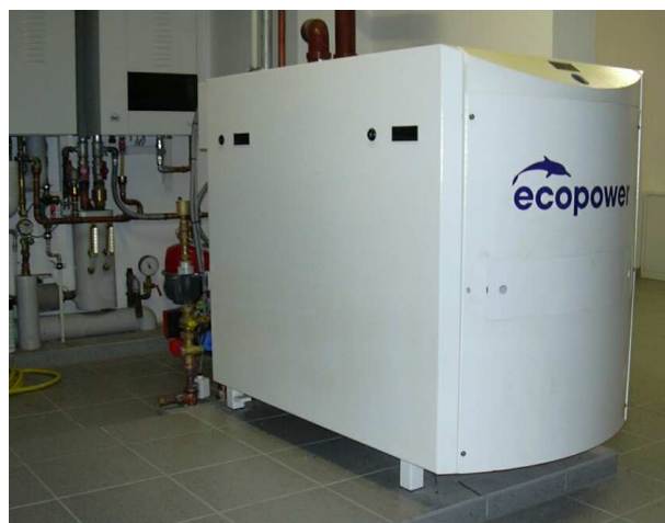
Bild 3.5: Rohrleitungen der Erdkältesonden (unten links) und Fußbodenheizkreise, Blockheizkraftwerk der Fa. Ecopower
