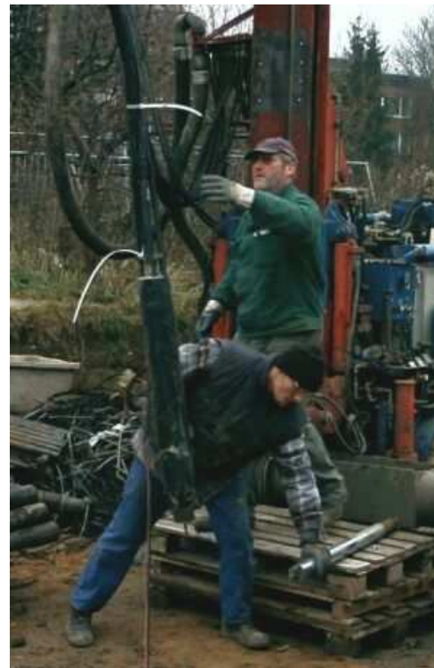
Bild 3.8: Einsetzen der Erdkältesonden für die Demonstrationsanlage
