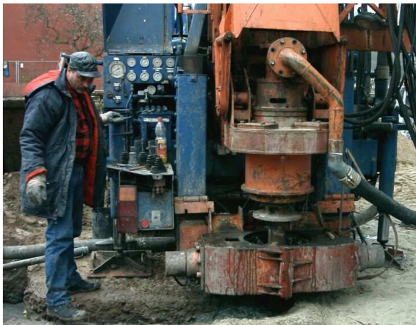
Bild 3.8: Einsetzen der Erdkältesonden für die Demonstrationsanlage
