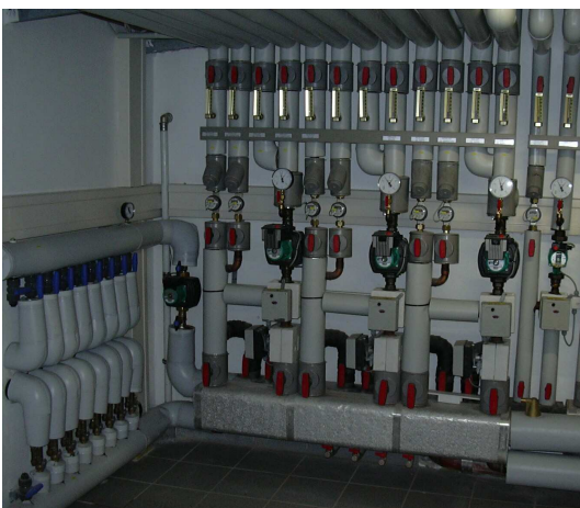
Bild 3.5: Rohrleitungen der Erdkältesonden (unten links) und Fußbodenheizkreise, Blockheizkraftwerk der Fa. Ecopower
