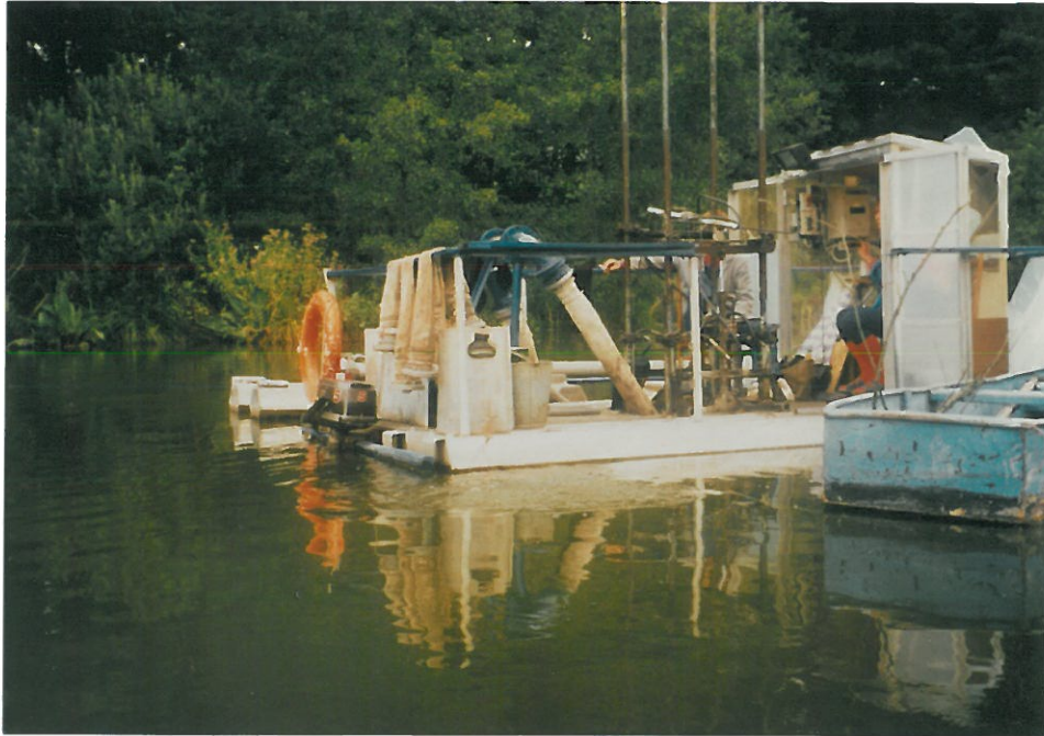
Bild 9: Arbeitsstellung des Gerätes
