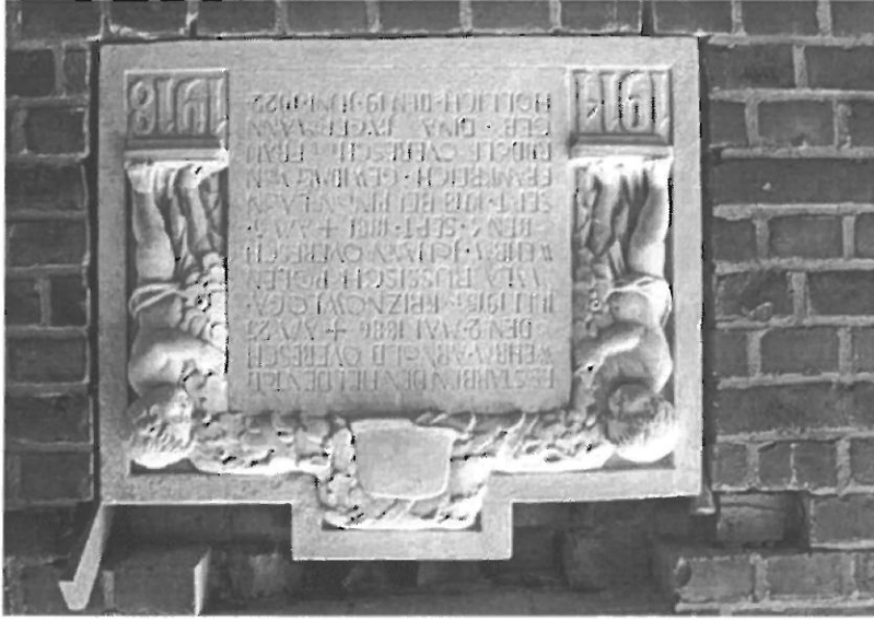
Die Gedenktafel vor und nach der Restaurierung; Nachträglich ist noch eine Verdachung, ebenfalls aus Kalksandstein, angebracht worden. So soll die direkte Beregnung der Gefallenenehrentafel weitestgehend ausgeschlossen werden.
