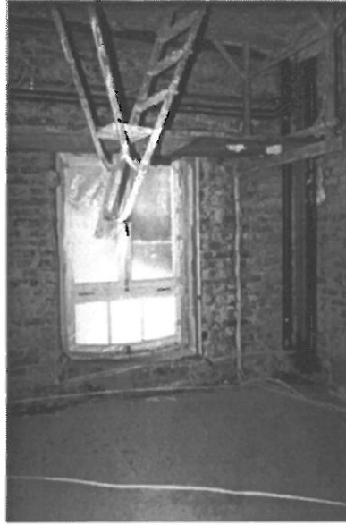
Die nachträgliche Innendämmung wurde besonders an den Fassadenbereichen dringend erforderlich, bei denen kein 2-schaliges Mauerwerk vorlag.
