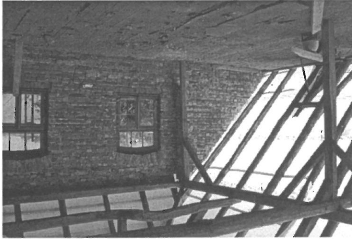
Das Dachgeschoss des Wohnhauses mit den Originalfenstern im Lasuranstrich. Auch hier, ebenso wie im I. OG, musste der Dielenboden aufgrund des schlechten Zustandes komplett erneuert werden.
