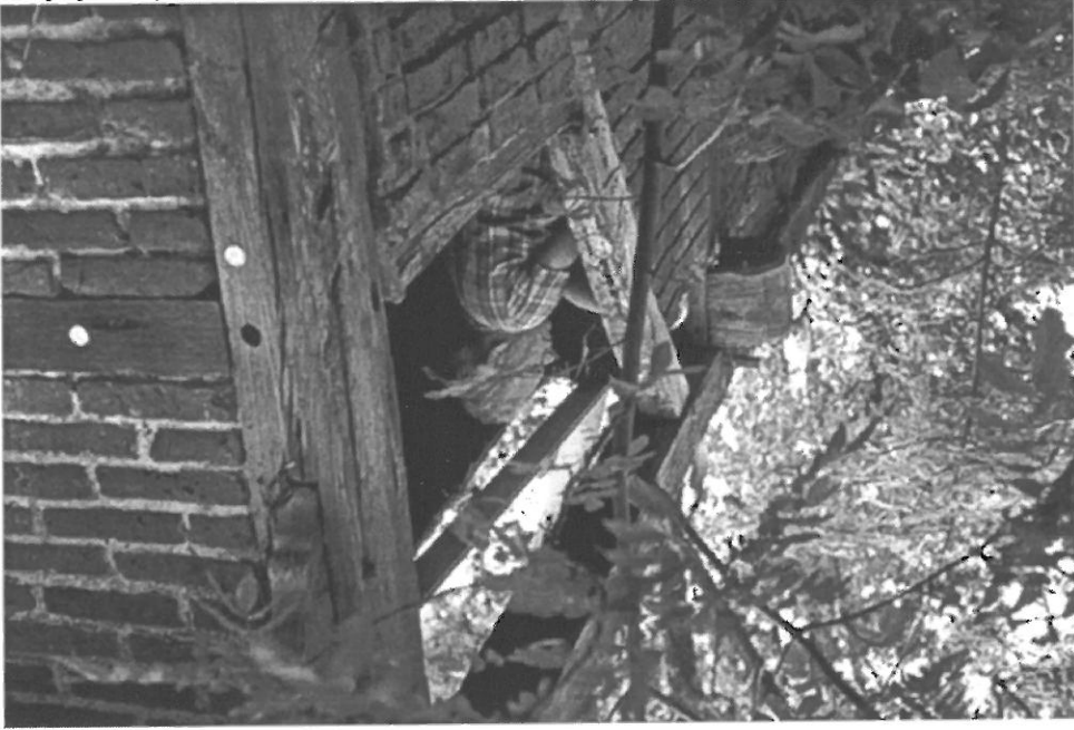
Jeder Holzbalken ist in seiner Lage und in seiner Aufgabe für die Statik des Holzständers in einem Nummernplan festgehalten, sodass ein Wiederaufbau nach der erforderlichen Restaurierung einzelner Bauteile problemlos möglich ist.
