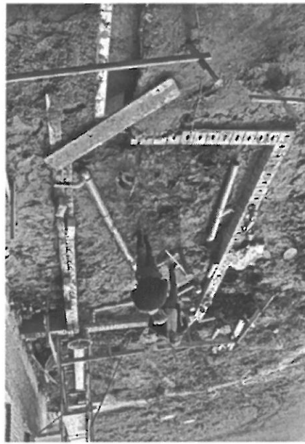
Die ersten vorbereitenden Arbeiten für den Toilettenanbau: das Erstellen der Gründung und das Verlegen der Abwasser- und der Versorgungsleitungen.
