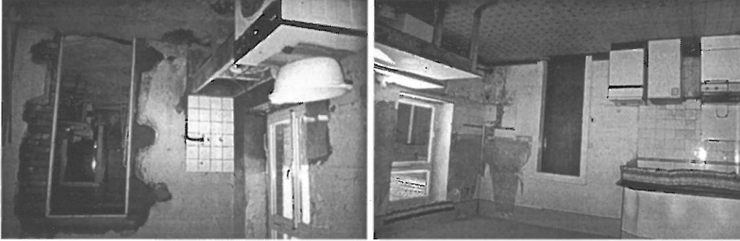
Die Wohnküche und die Waschküche während der umfangreichen Instandsetzungsarbeiten 1991
