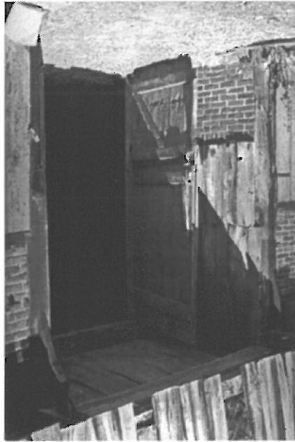
Die 'Niederöcker', das hintere Eingangstor zum Arbeitsbereich Stall, für Mensch und Tier und zugleich die Einfahrtsöffnung für den Erntewagen. Der Dachüberstand, die Auskragung des Giebels, schützt die Fachwerkwand und ermöglicht das bessere Erreichen der Klappen zum Heulager.
