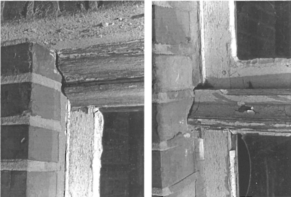
Der Kämpfer und die Sohlbank, die unteren Rahmenhölzer, sind durch stark gerundete Profile wichtige konstruktive und auch gestalterische Elemente. Sie dienen der Betonung der Wagerichten, garantieren zudem den Ablauf des Regenwassers. Die Profilierung schützt die unteren Rahmenhölzer vor Verwitterung.
