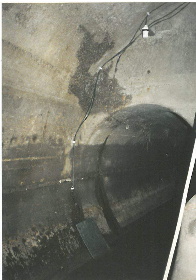
Bild 13: Wasserstands- und Geschwindigkeitsmessung im Oberwasser des Drehbogens
