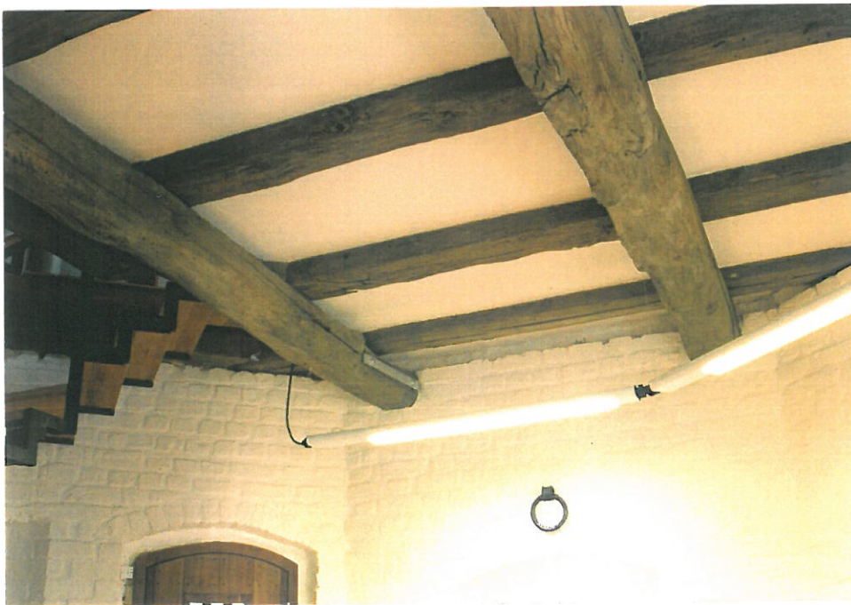
Balken und Decken im Turm 12/95
